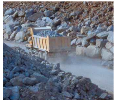
Staubentwicklung am Beispiel Baustelle Gotthardtunnel / Schweiz (Foto: Franz Thomann, Nov. 2001)
