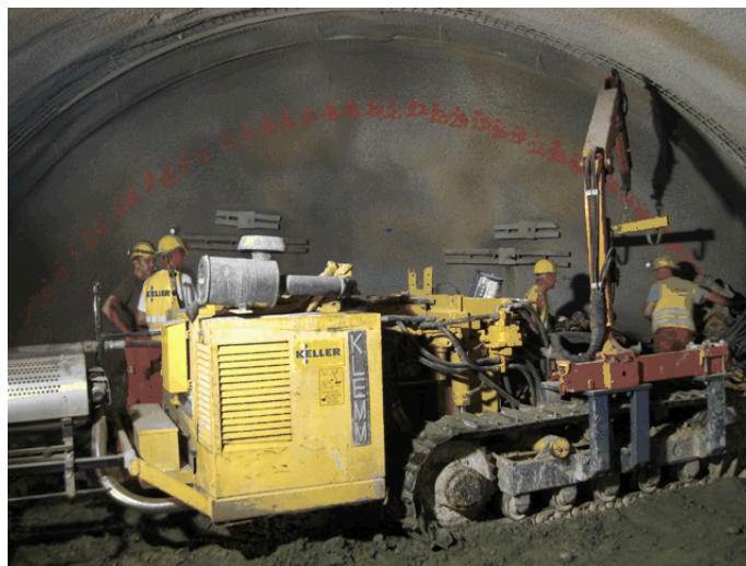
Aktuelle Vortriebsposition: Unter der Gleinzerstraße
