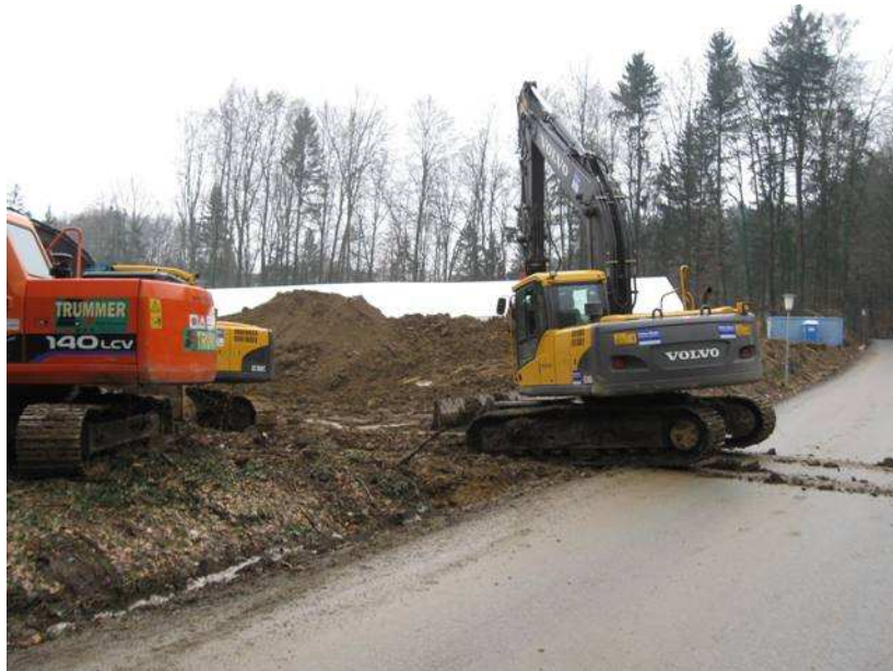
Auf dem Foto sieht man das Abtragen der Humusschicht. Im Hintergrund ein beheiztes Zelt unter dem aktuell die Grabungen durchgeführt werden.
